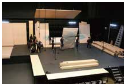
かがみいた ぼしら 鏡板やシテ柱を設置していく
