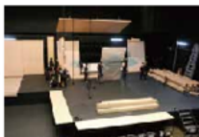
つらねの 筋板やシテ柱を設置していく
